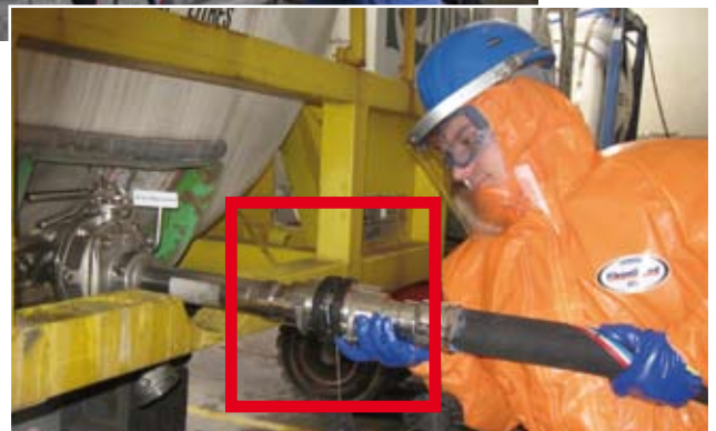
TKU mit Rohrverlängerung im Realeinsatz: vor dem Kuppeln.
