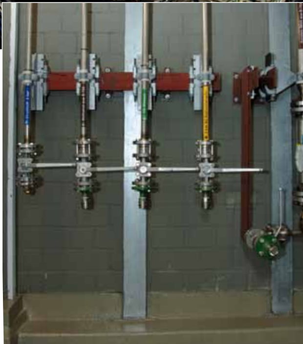
Sicherheitskammer mit Sicherheitstechnik: TR-Vaterteile an allen Schnittstellen.
